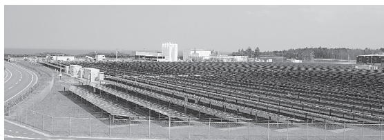
福島水素エネルギー研究フィールド全体
